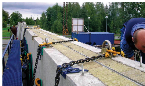
Seinäelementtikuorma sidotaan nostolenkkien läpi ja elementtien kulmat suojataan ketjulta.
