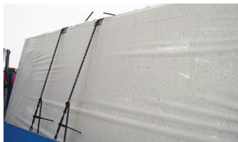
Seinäelementit voidaan suojata kutistemuovilla varastoinnin ja kuljetuksen ajaksi. Huomaa kulmasuojat.
