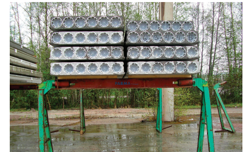
Ontelolaatat valmiskuormapukeilla. Pukkien jalkojen alla tulee olla riittävän kantava maapohja. Tarvittaessa käytetään aluslevyjä.
