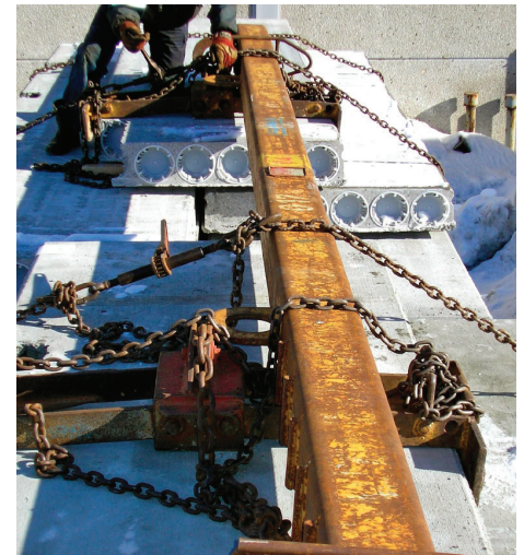
Nostopuomi kulkee kuorman päälle sidottuna työmaalle.
