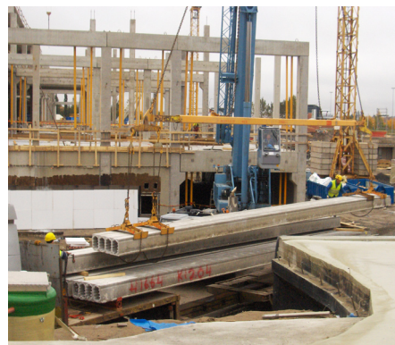
Kuva 17. Ontelolaatan nostoissa käytetään nostopuomia, joka on varustettu nostosaksilla ja varmuusketjulla. Alle kolme metriä pitkät laatat voidaan nostaa ilman nostopuomia, jos haarakulma on alle 10 astetta. Raskaat ja pitkät ontelolaatat nostetaan käyttäen useampaa kuin kahta nostosaksea laatan pituudesta riippuen.
