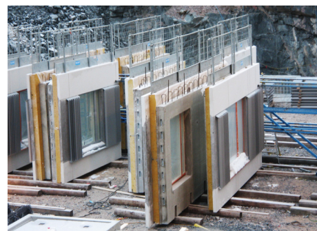
Hyvä käytäntö on kiinnittää kaiteet elementteihin jo ennen niiden paikalleen asentamista.
