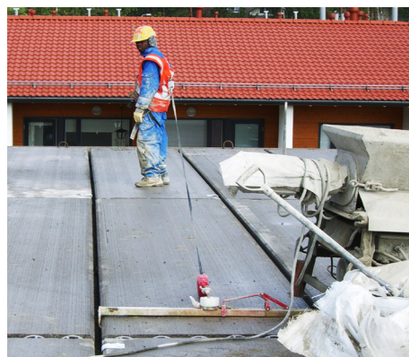
Ontelolaatta-asennuksessa suositellaan käytet-tävän henkilökohtaista putoamissuojausta.
