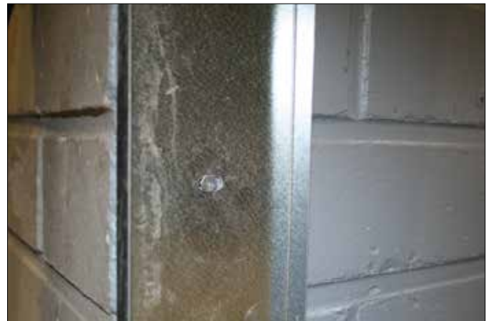
U-lista kiinnitetään lähtöseinään esim. naulatulpilla.
